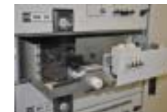
Рис. 7. Выдвижной модуль для распределения электроэнергии с автоматическим выключателем
