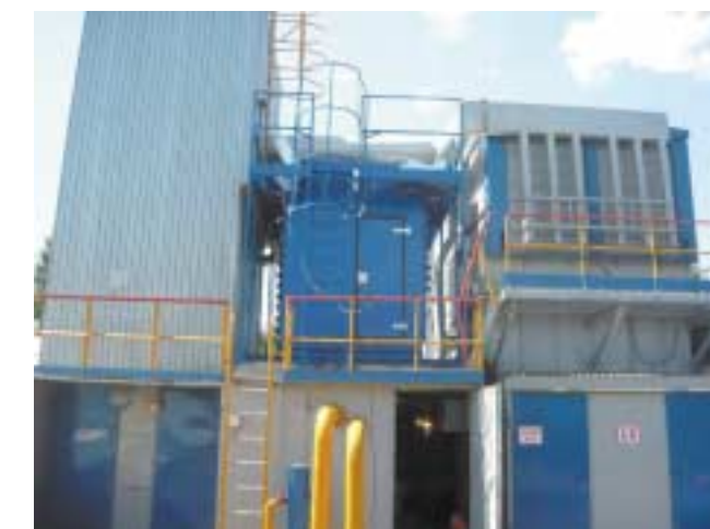
Фото 6. ГПА-Ц-6,3/56М после капитального ремонта
