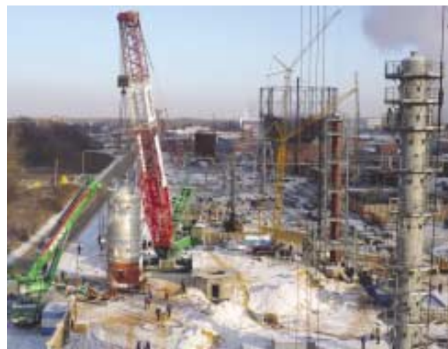
Подъем реактора на ОАО «Щекиноазот»
