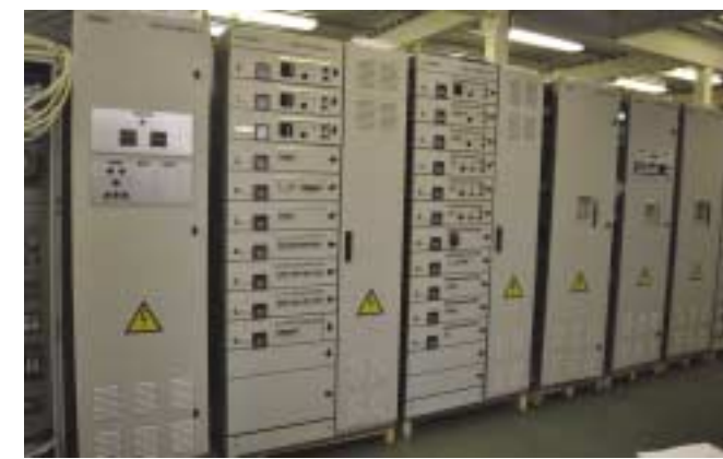
Рис. 5. Шкафы с выдвижными модулями серии SEN+
