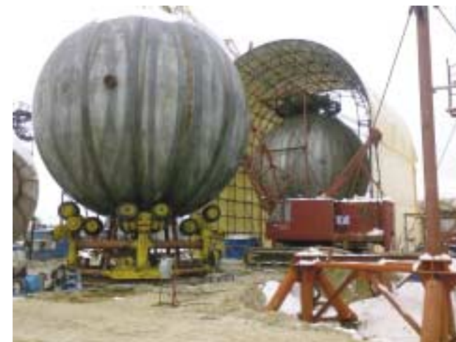
Монтаж шаровых резервуаров на строительстве Пуровского ЗПК
